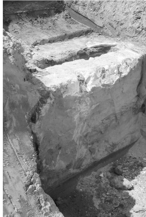
Fotografia 2. Widok odsłoniętej przegrody przeciwfiltracyjnej wykonanej metodą szczeliny kopanej Photo 2. View of slurry wall uncover built by cut-off method
