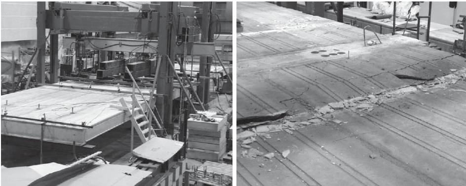
Rys. 5. Zniszczenie stropu z płyt kanałowych przez ścinanie Fig. 5. Failure of hc floor slab by shear [Research Report... 2006]
