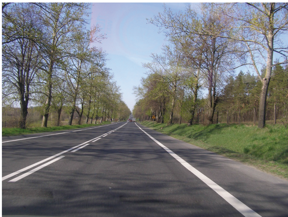
Fotografia 5. Drzewa przy drodze E7 między Białobrzegami i Grójcem, przed budową drogi ekspresowej S7, kwiecień 2007 r. (fot A. Marosz)
