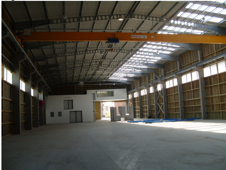
Bild 1. Neue Sägehalle in Kalisz Pomorski vor der Montage (fot. Krzosek)
