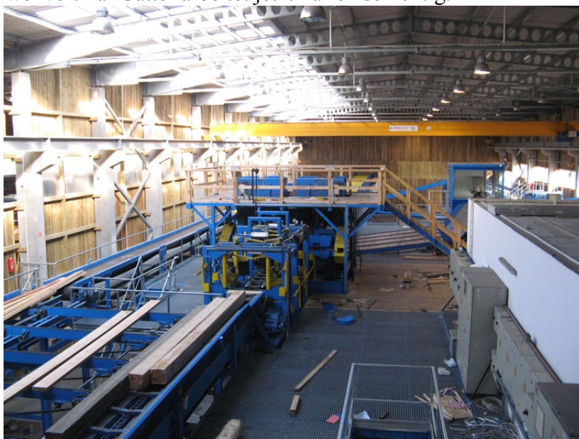
Bild 4. Inbetriebnahmephase in Sägewerk in Kalisz Pomoski (fot. Maleta)
