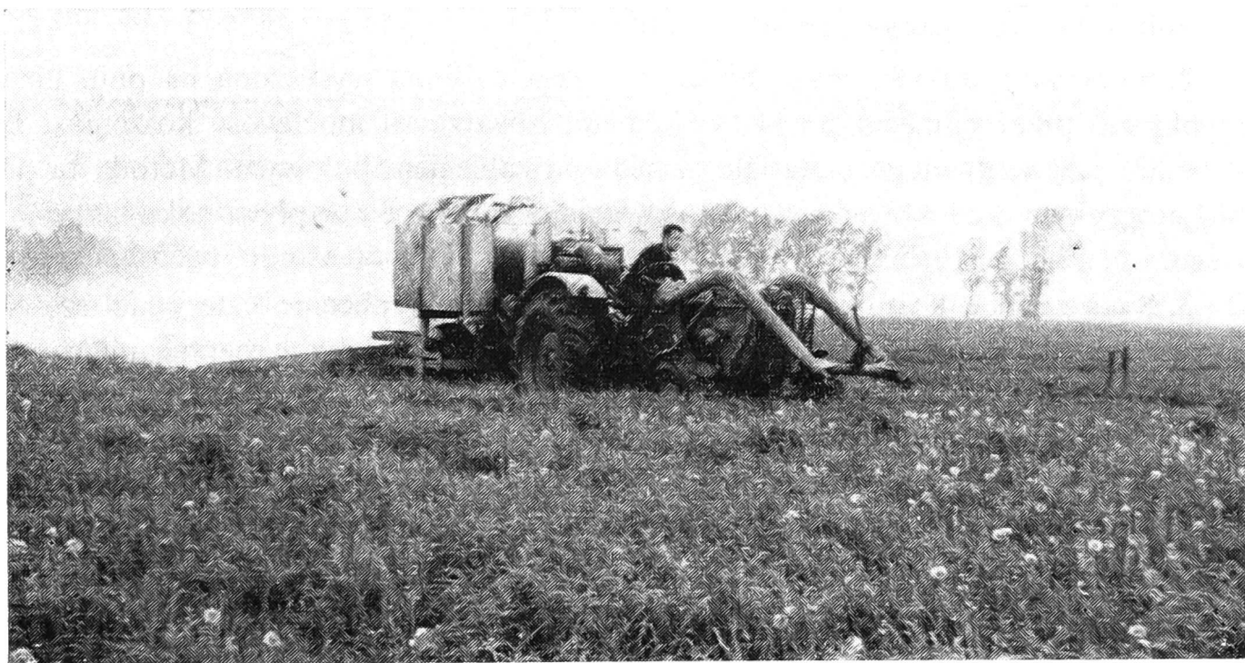
Rys. 4. Doświadczalna maszyna skonstruowana w IBVL do „zabijania” porostu roślinnego parą wodną
