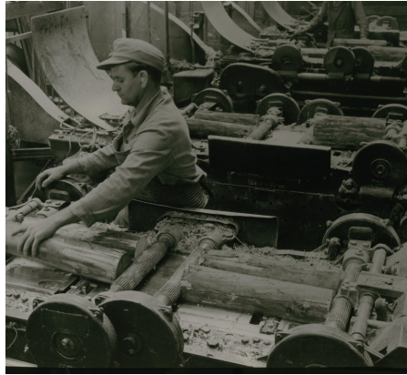
Bild 2. Holzwole a) „unbeschlämmt“ 1964 (Quelle: Heraklith), b) : manuelle Holzwoleherstellung („Hobler an der HWM- Holzwollemaschine“) 1964 (Quelle: Heraklith)
