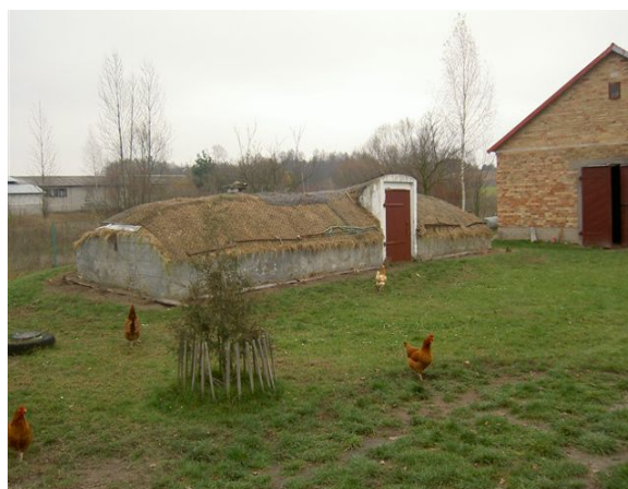
Fot. 4. Piwnica dwunawowa
