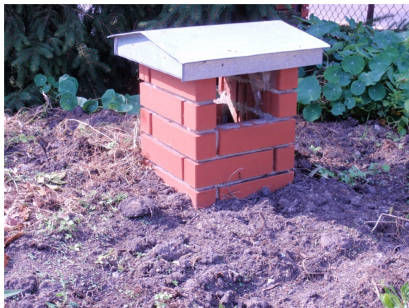
Fot. 6. Budowa wywietrznika w piwnicy
