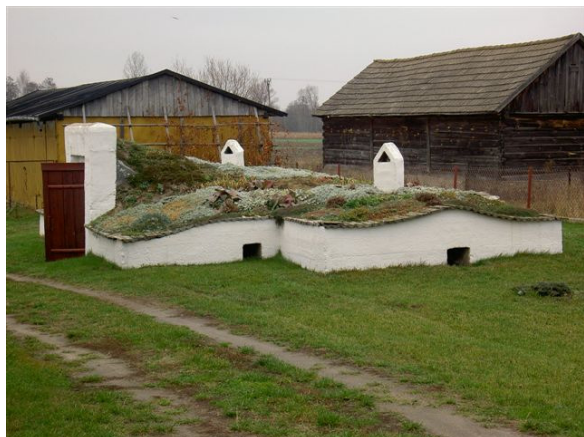
Fot. 5. Piwnica dwunawowa z przedsionkiem
