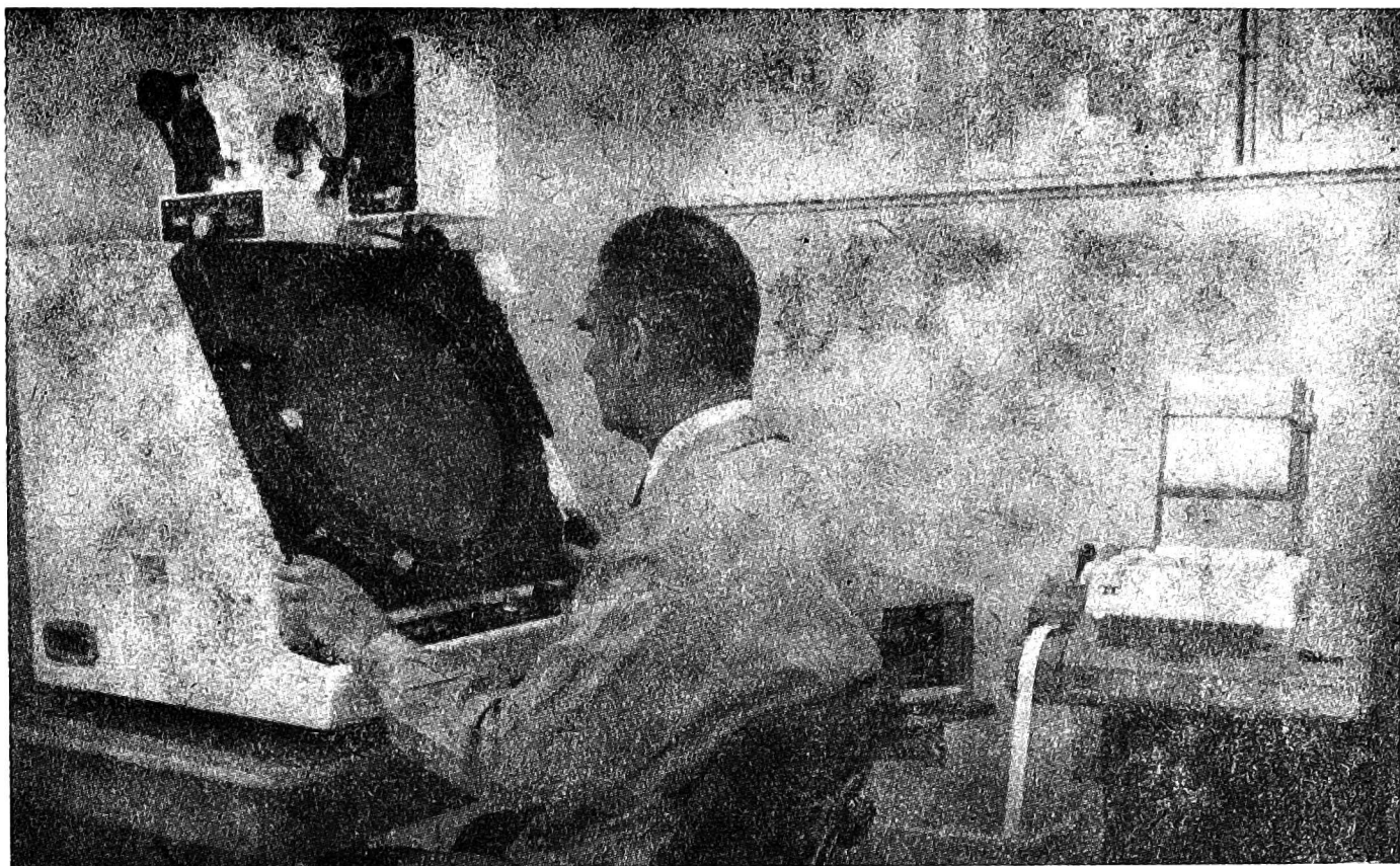
Rys. 2. Analizator współrzędnych x-y dający 23-krotne powiększenie klatki filmu 16 mm, połączony poprzez interfejs z elektryczną maszyną do pisania, na której jest równocześnie perforowana taśma z odczytanymi danymi, co umożliwia wprowadzenie tych danych do komputera. Fotografia pochodzi z Narodowego Centrum Filmu Badawczego Węgierskiej Akademii Nauk w Budapeszcie
