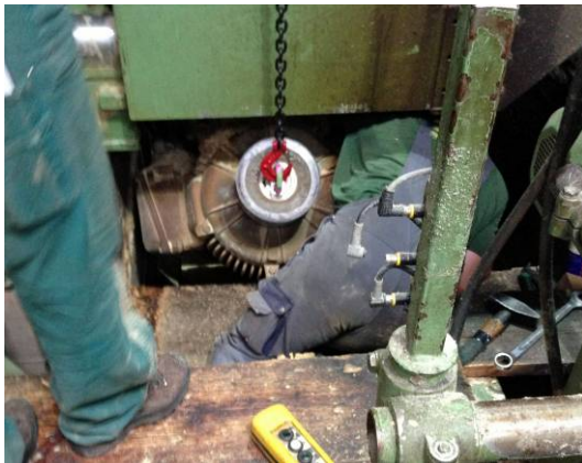
Bild 5 Austausch der Hauptmotoren der Bandsägen und der Horizontalkreissäge (Quelle: Dietz WCT)
