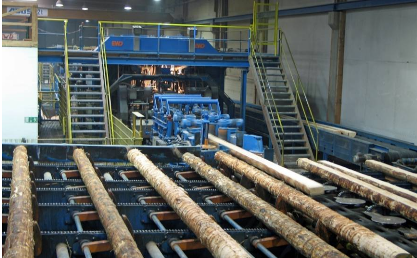
Bild 3 Installation II, Sägewerk Eigelshoven (Quelle: Dietz WCT)
