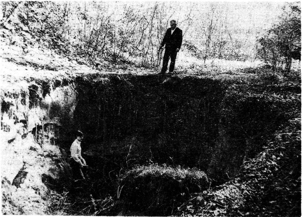
Rys. 7. Rozmywany próg na dnie wąwozu na hm 2+30. Wiosna 1972 r.
