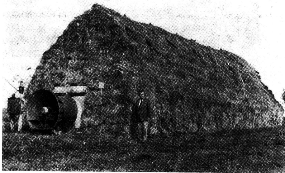
Rys. 12. Sterta do dosuszania siana zbudowana według systemu opracowanego w IMER
