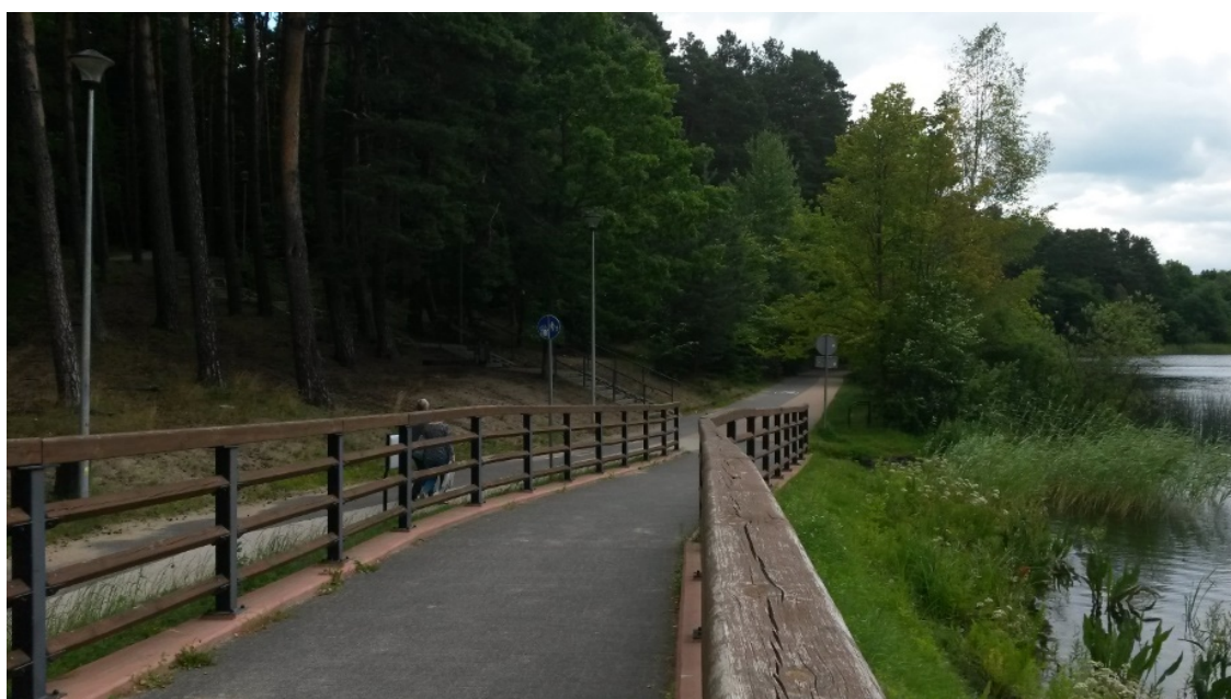
Fot. 4. Fragment nowego mostu na Jeziorze Długim oraz ścieżka spacerowa i rowerowa, maj 2017 Photo. 4. Fragment of a new bridge on Długie Lake, and biking and walking path, May 2017
