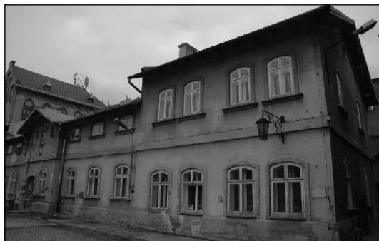
Fot. 3. Budynek administracyjny B w Kwartale w Kwartale św. Wawrzyńca przed modernizacją Źródło: Muzeum Inżynierii Miejskiej w Krakowie Fig. 3. An administrative building B in St. Wawrzyniec Quater before restoration Source: Cracow Museum of Urban Engineering
