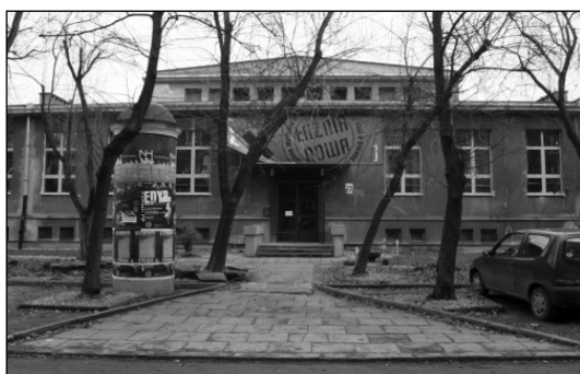
Fot. 5. Teatr „Łaźnia Nowa” przed modernizacją
