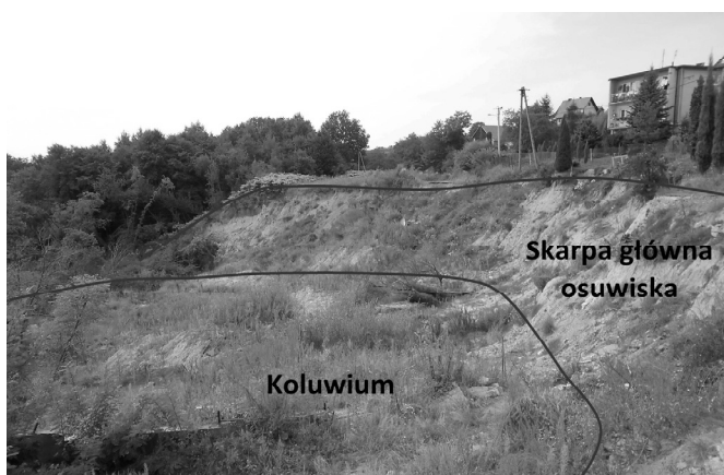
Rys. 1. Widok skarpy osuwiska
