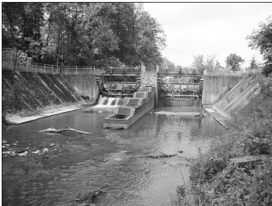
Rysunek 2. Jaz w Bieńczycach – widok od strony dolnej wody Figure 2. Weir at Bieńczyce – view from down water
