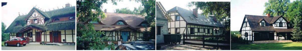
FIGURE 2. Selected examples of modern skeleton constructions alluded to traditional post-and-beam solutions in Cassubian huts – dwelling houses, Karwieńskie Błota (photo by Mirosława Górecka) RYSUNEK 2. Wybrane przykłady współczesnych konstrukcji szkieletowych nawiązujących do tradycyjnych rozwiązań ryglowych w chałupach kaszubskich, domy mieszkalne, Karwieńskie Błota (fot. Mirosława Górecka)
