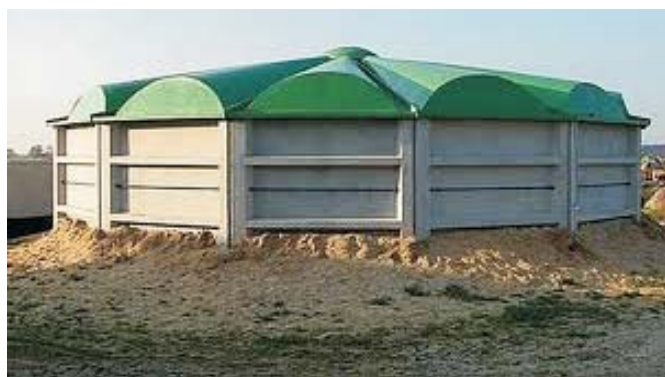
Rys. 1. Przykład betonowego zbiornika na gnojowicę [6] Fig. 1. An example of a concrete manure tank [6]
