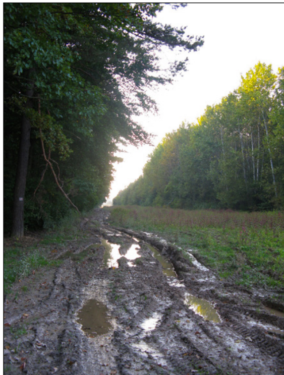
Ryc. 2. Przykład typowych utrudnień występujących na szlakach rowerowych w nadleśnictwie Celestynów na siedliskach podmokłych – koleiny widoczne w nawierzchni
