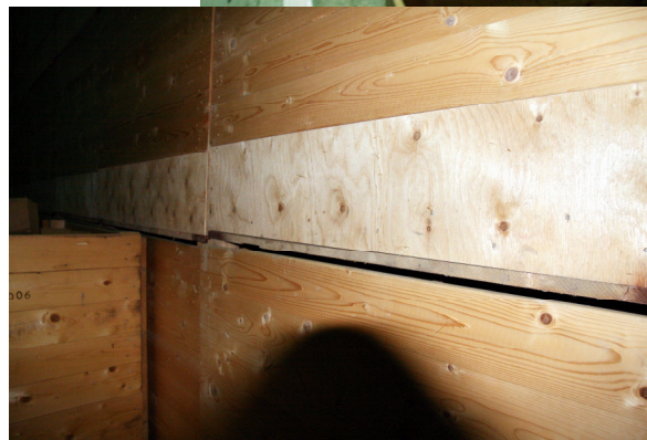
Fot. 1. Nietypowy system przewietrzania skrzyniopalet, wymusza przemieszczanie się powietrza od ściany kanałem pod dnem każdej skrzyni, a następnie ku górze przez masę ziemniaków, gdzie następnie znajduje ono ujście jedynie małą szczeliną w górnej części boku kontenera (fot. autora)
