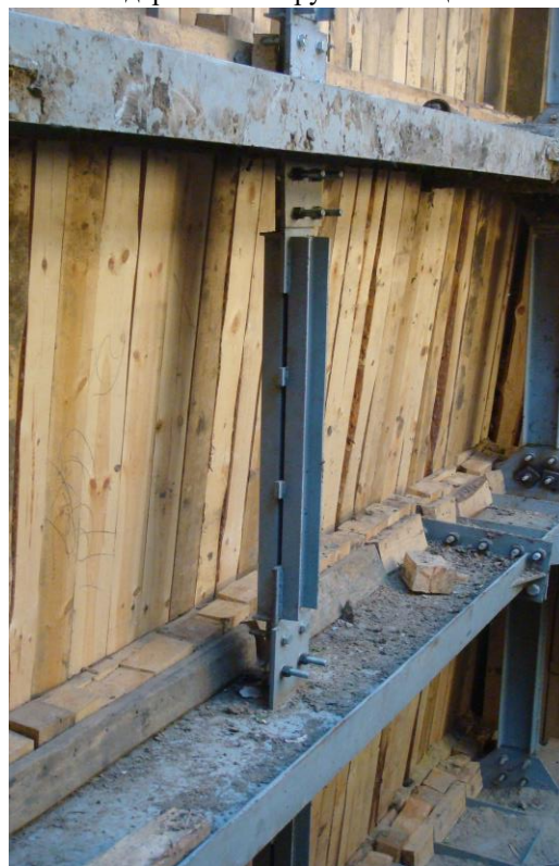
Рис. 7. Крепь для проведения ремонтно-восстановительных работ
