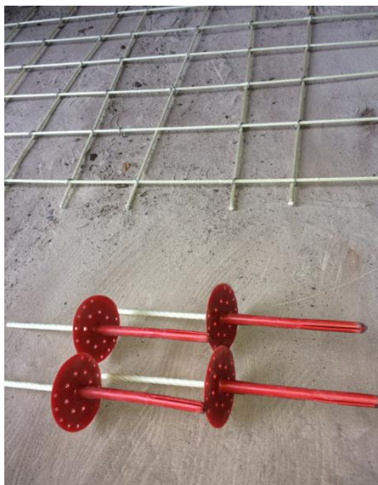
Рис. 8. Армирование стеклопластиковой арматурой сводовой части коллектора
