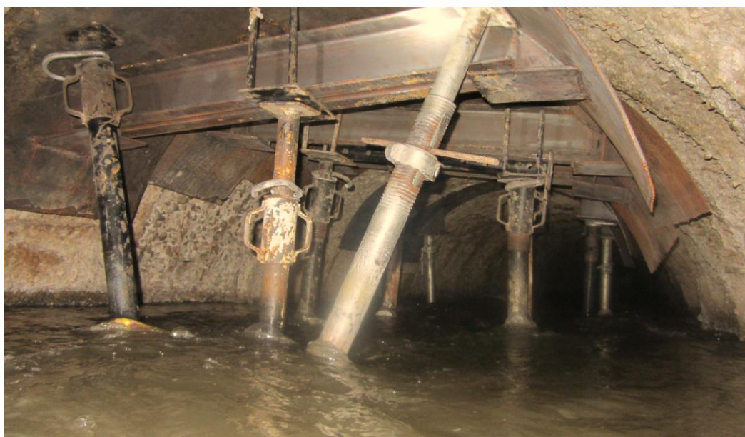
Рис. 5. Фотофиксация состояния конструкций тоннельного коллектора
