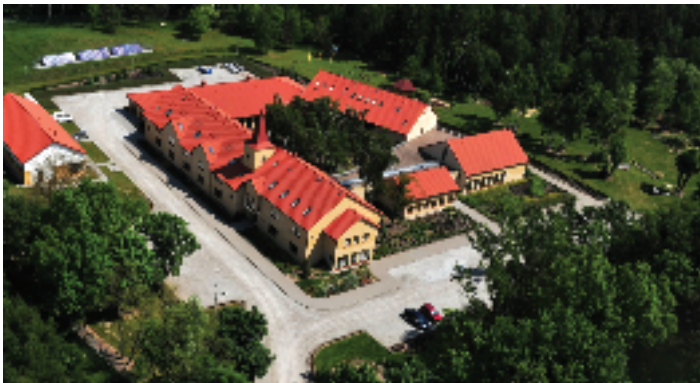
Fot. 4. Widok na Ośrodek Konferencyjno-Rekolekcyjny Archidiecezji Łódzkiej w Uroczysku Porszewice. Widoczny system solarów wspomagających system podgrzewania wody (fot. A. Grad)
