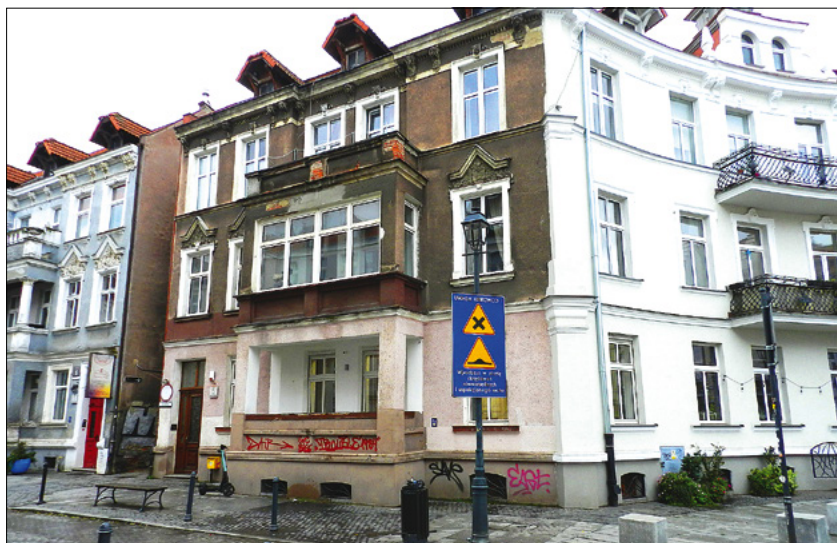
Kamienica przy ulicy Wajdeloty 5 w Gdańsku-Wrzeszczu, gdzie na parterze mieści się nowa siedziba Izby Kaszubsko-Pomorskiej
