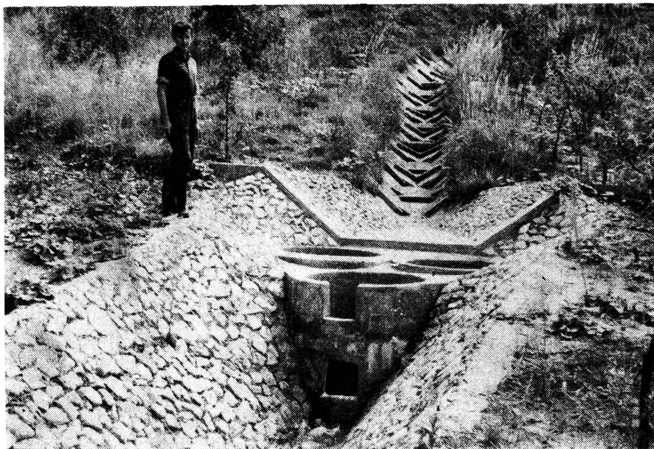
Rys. 7. Wylot bystrotoku umocniony ścianką betonową i brukiem. Trzy kręgi betonowe tworzą zbiornik rozpraszający energię wody. Specjalne otwory łączą kręgi, a widoczne na zdjęciu odprowadzają wodę do rowu. 1972 r. Fot. S. Ziernicki
