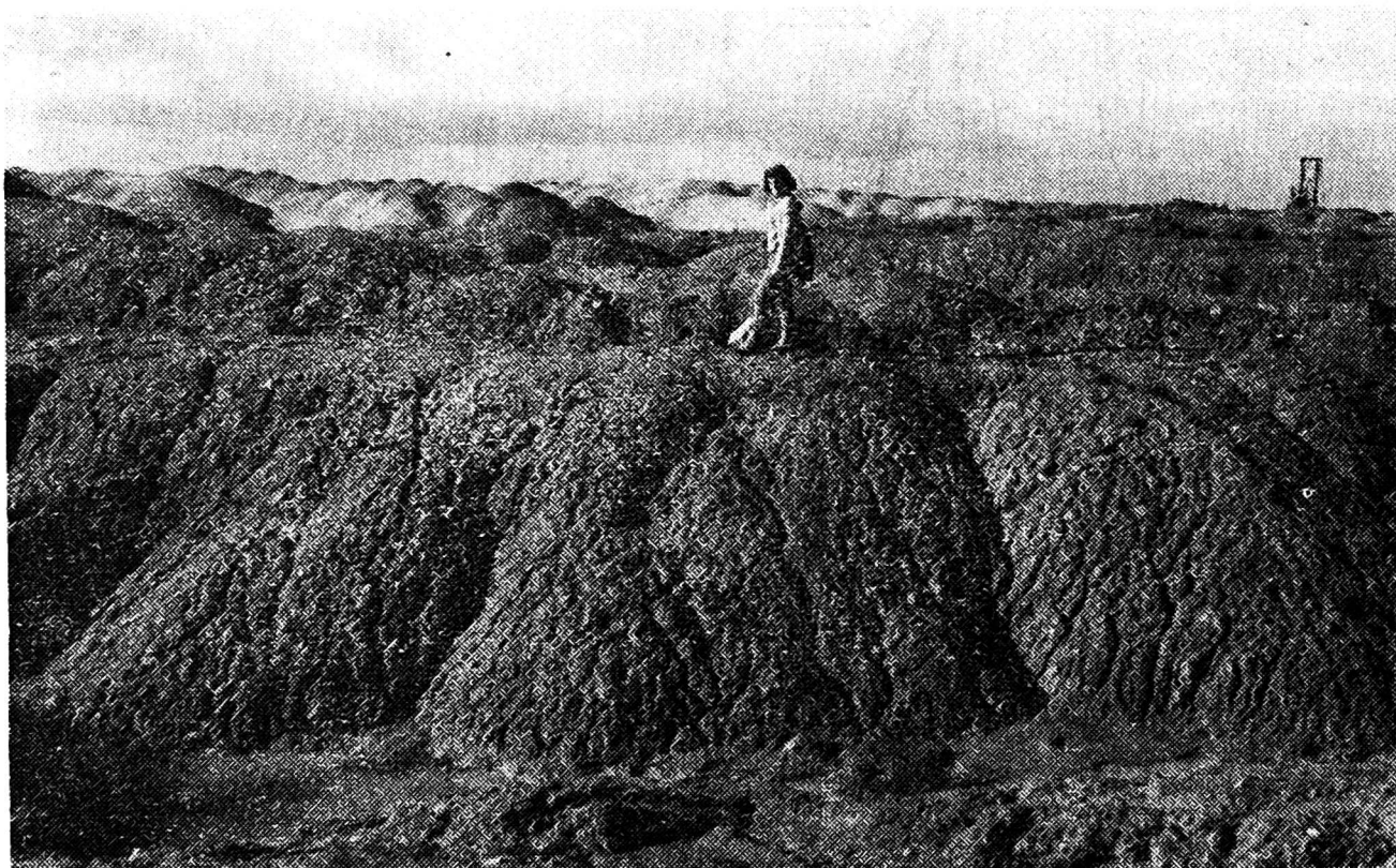
Rys. 3. Część wierzchowinowa zwałę w Piasecznie. Widoczne są groble — grzbiety i dolinki, którymi okresowo odpływała woda. 1966 r. Fot. S. Ziemnicki
