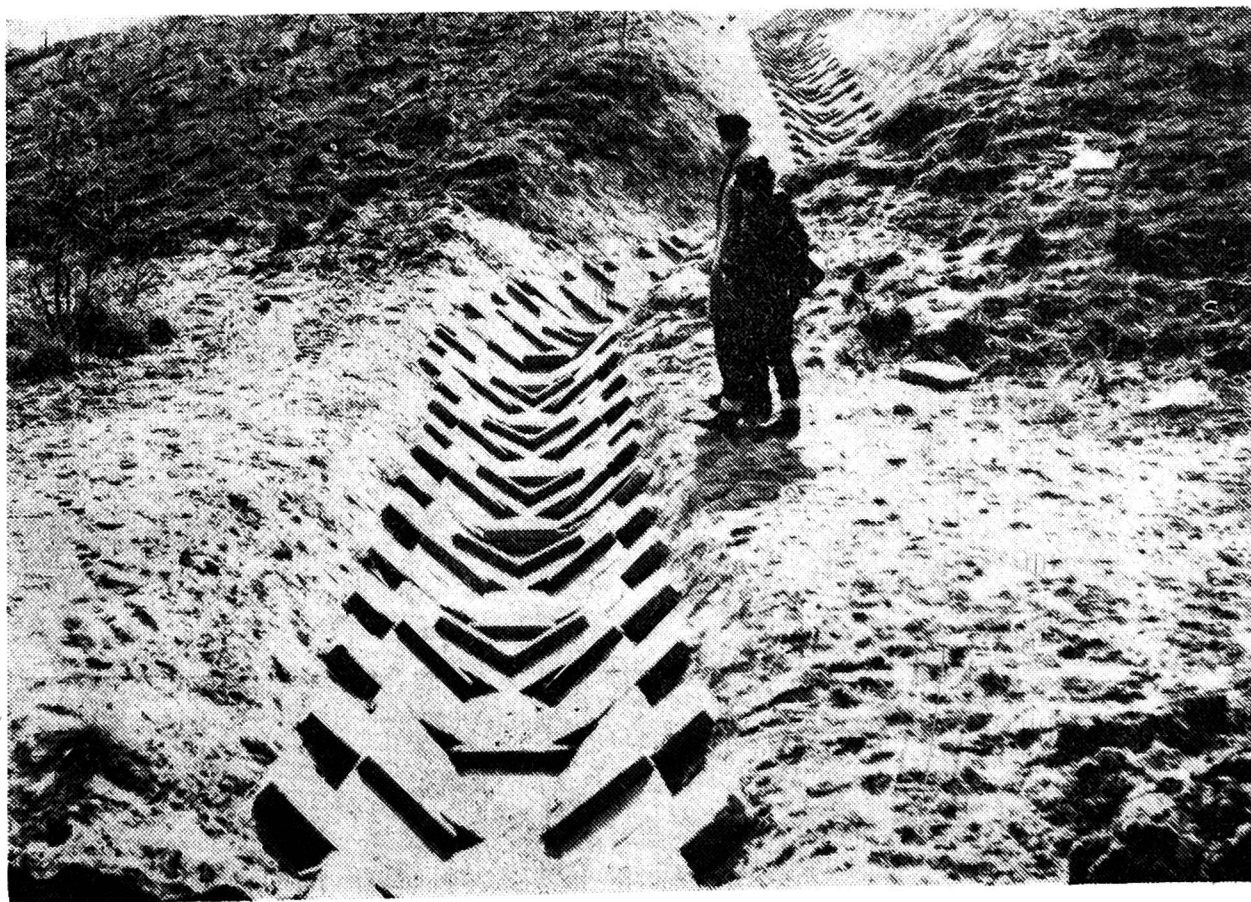
Rys. 6. Bystrotok w czasie budowy. Na dnie bystrotoku widoczne są niskie szykany hamujące spływ wody i rozpraszające jej energię. Piaseczno 1968 r. Fot. S. Ziemnicki
