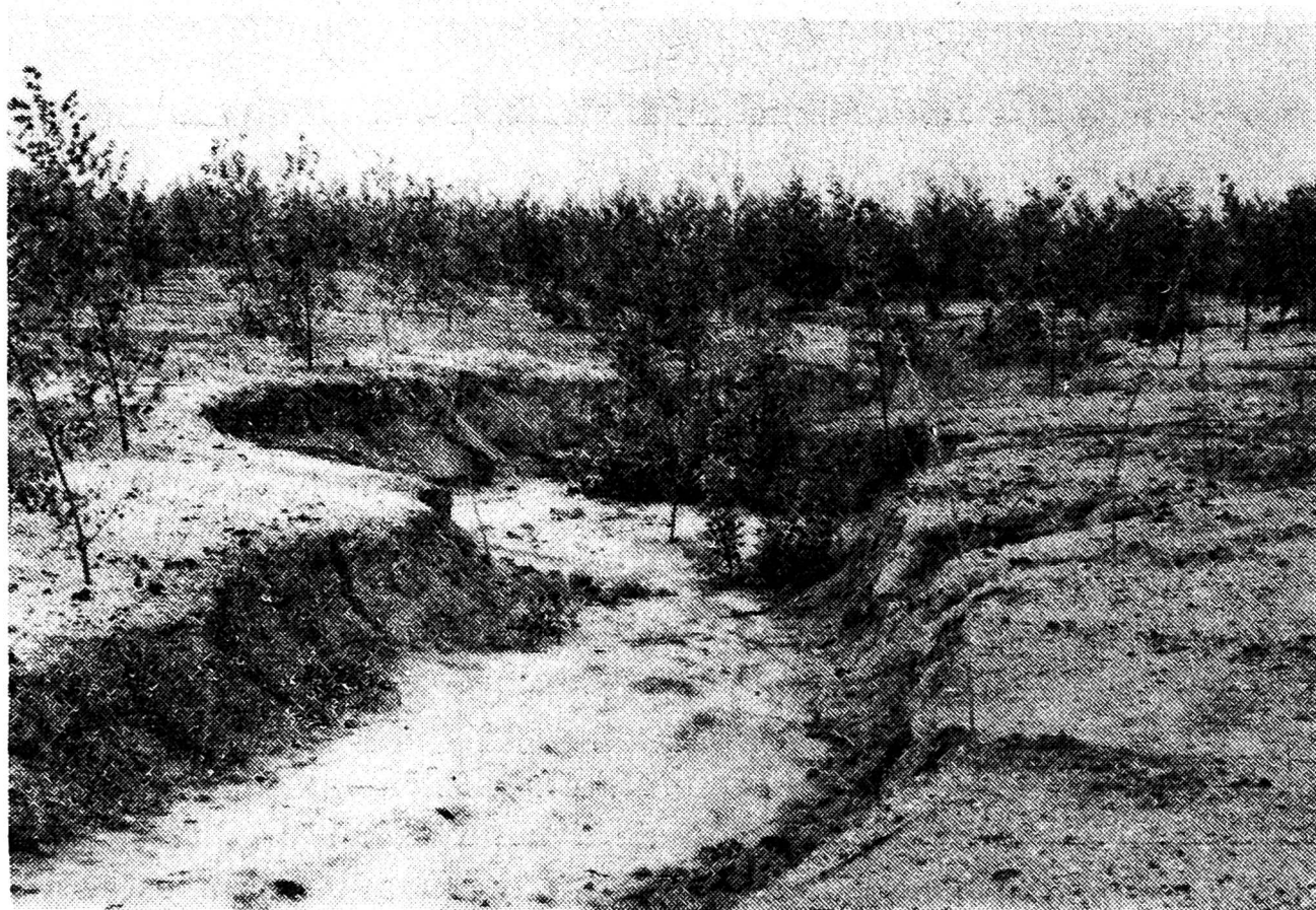
Rys. 9. Zwał kopalni odkrywkowej węgla brunatnego w okolicy Lipska. Zbocze o małym nachyleniu ulega silnej erozji, pomimo obsadzenia drzewami.
