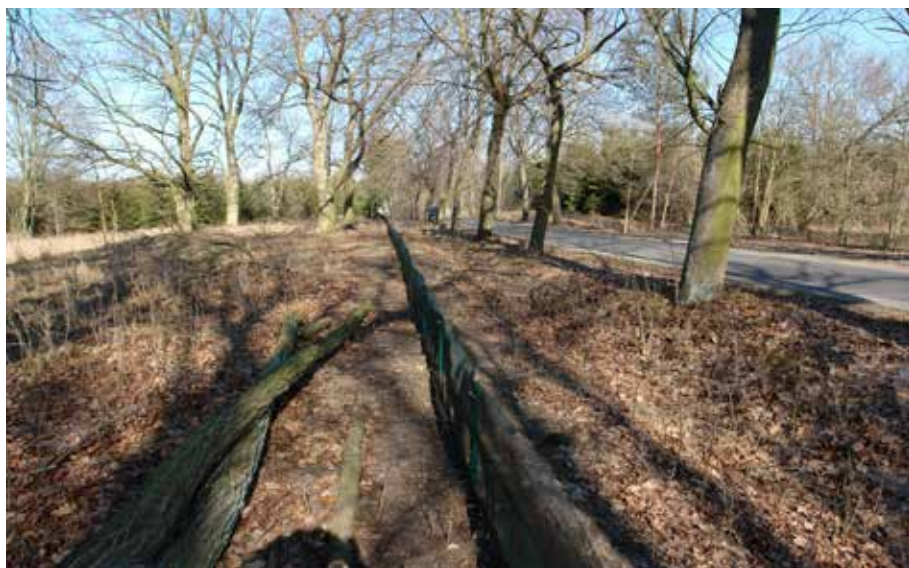
Fot. 4. Stałe przejście dla płazów Photo 4. Permanent path for amphibians
