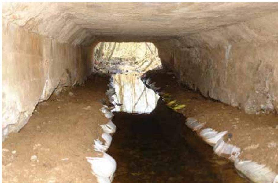
Fot. 5. Suche przejście dla płazów pod mostem Photo 5. Dry path under the bridge for amphibians
