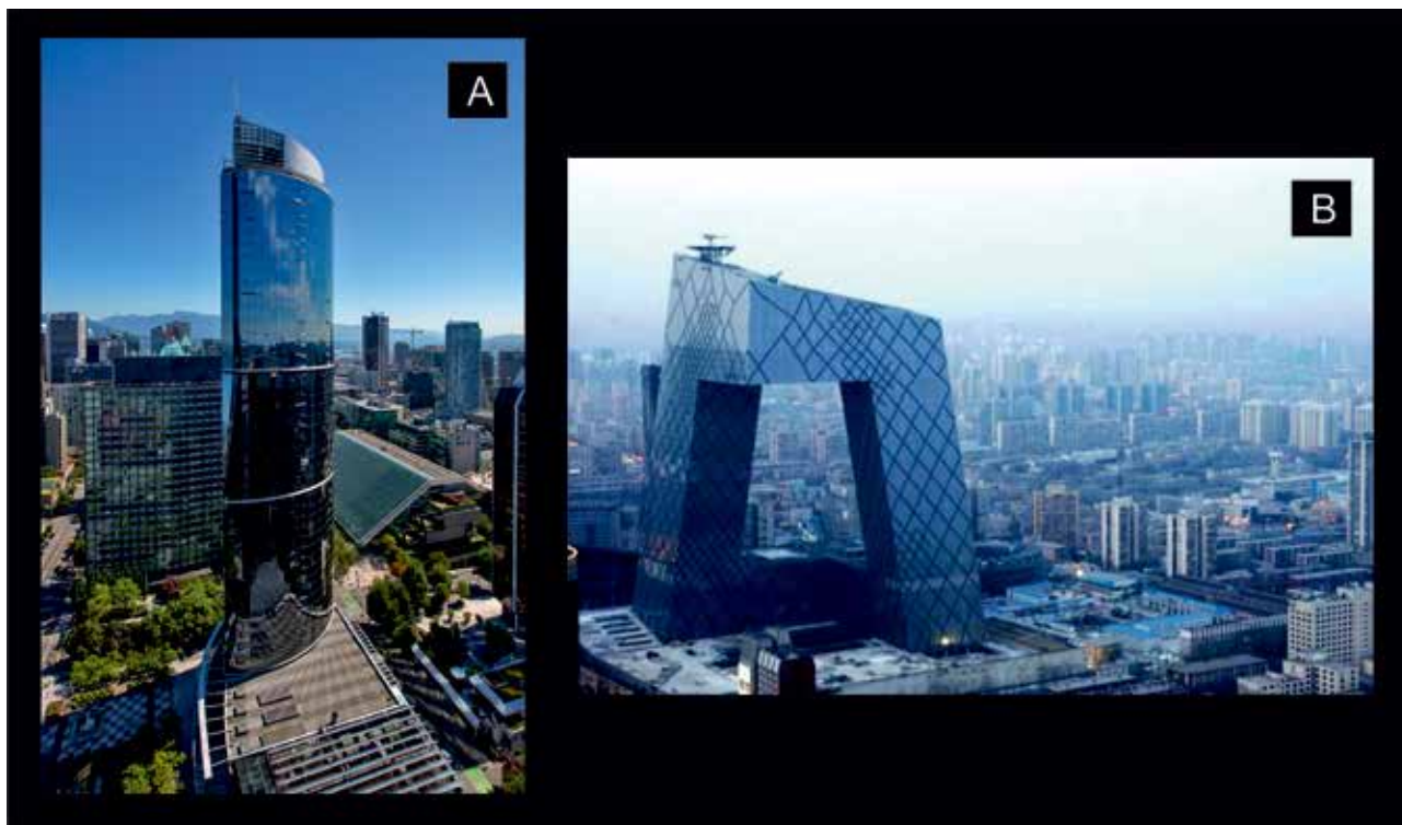
Ryc. 7. Zdjęcie budynku One Wall Centre w Vancouver (A) i budynek chińskiej telewizji CCTV, na którym widoczna jest siatka zabezpieczająca konstrukcję (B). Źródło: Takewaki, 2001; Ventura i in., 2002 [3,13]
