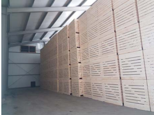
Fot. 8. Inwestycja w nową przechowalnię na 1100 t z nowoczesnym systemem wentylacyjnym i chłodniczym (fot. A. Płotka)
