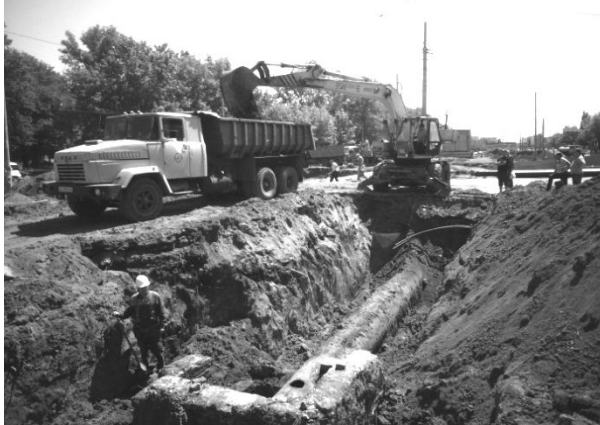
Рис. 5. Разработка грунта и устройство траншеи под замену участка водовода
