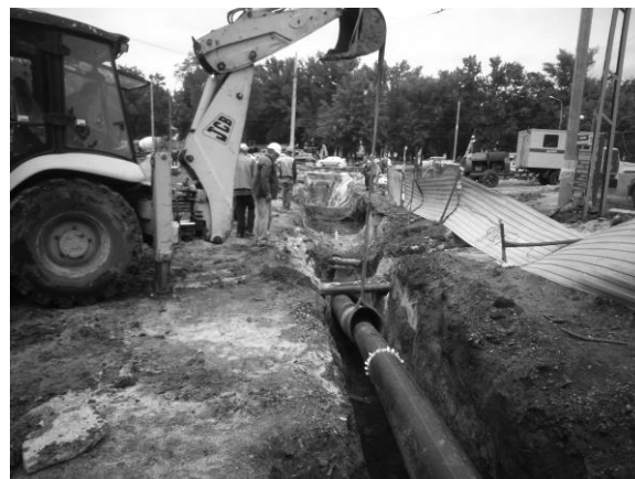
Рис. 11. Монтажные работы сети по ул. Кошкина Fig. 11. Pipe installation by Koshkin str.
