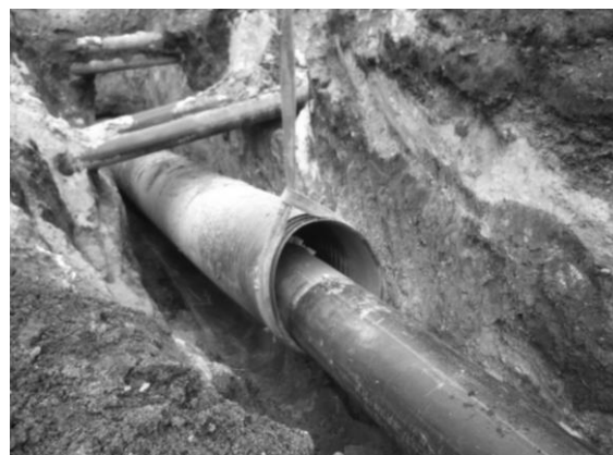
Рис. 12. Монтаж РЕ водопроводной сети в кожух Fig. 12. Installation of PE water supply in housing
