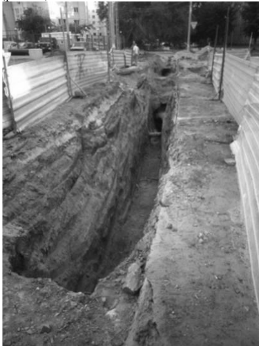
Рис. 11. Открытие траншеи для строительства водопроводной перемычки
