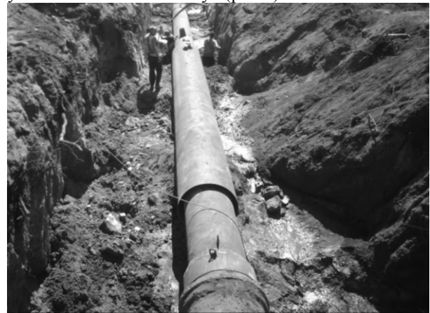
Рис. 8. Монтаж водовода в кожух
