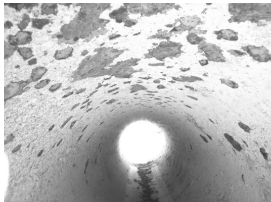
Рис. 4. Внутренняя стенка стального водовода DN 900
