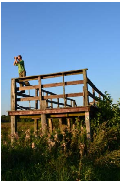
Fot. 2. Platforma obserwacyjna na trasie ścieżki przyrodniczej „Barwik” Photo 2. The observation platform on the trail path „Barwik”
