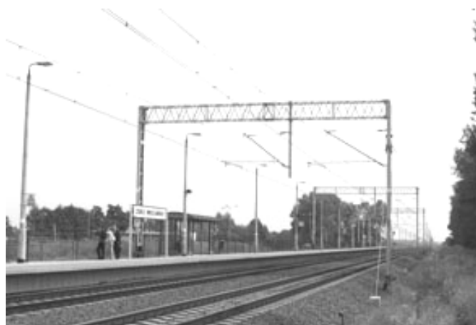
Ryc.2 Nowoczesna infrastruktura stacji i przystanków osobowych o ujednoliconej budowie (Zębice Wrocławskie, szlak E-30)
