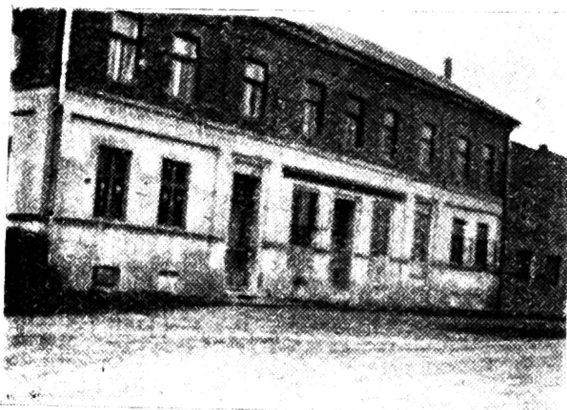
Rycina 1. Widok ogólny. Front fabryki.
