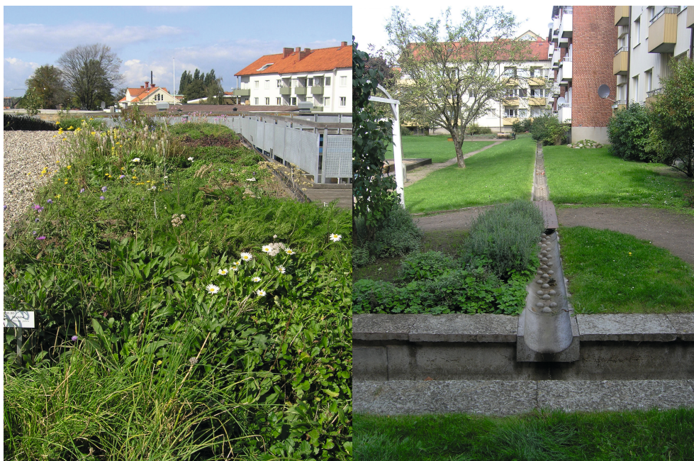
Ryc. 2 i 3. „Eko-Miasto Augustenborg” w Malmö. Po lewej: Ogród Botaniczny na dachu. Po prawej: otwarty system zagospodarowania wód deszczowych - fragment (autor fot.: P. Wolski).
