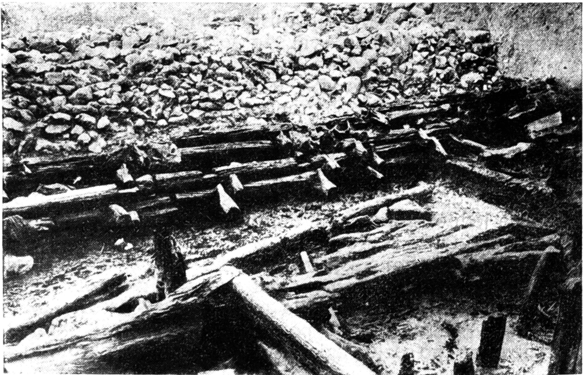
Ryc. 6. Poznań. Na pierwszym planie konstrukcje domu, w głębi część wczesnośredniowiecznego wału drewniano-kamiennego. Wg W. Hensla (6)
