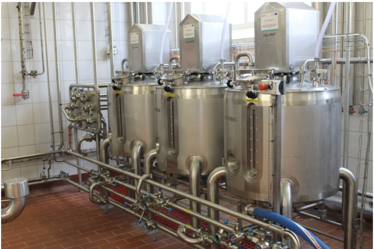
Fot. 1. 2. Dział Technologii i Wdrożeń. Pilotowa hala technologiczna (fot. M. Śliwiński) Technology and Implementation Department. Pilot Plant.
