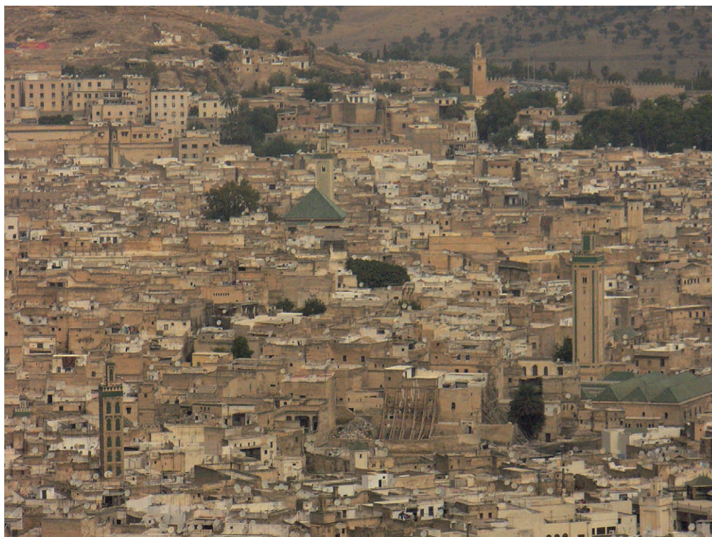
Fot. 9. Fez, widok ogólny medyny Źródło: Zbiory własne autorki. Phot. 9. Fez, a general view of medina Source: Taken by the author.
