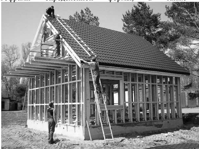
Рис.3. Балка HTS в качестве несущих элементов каркаса малоэтажного дома
