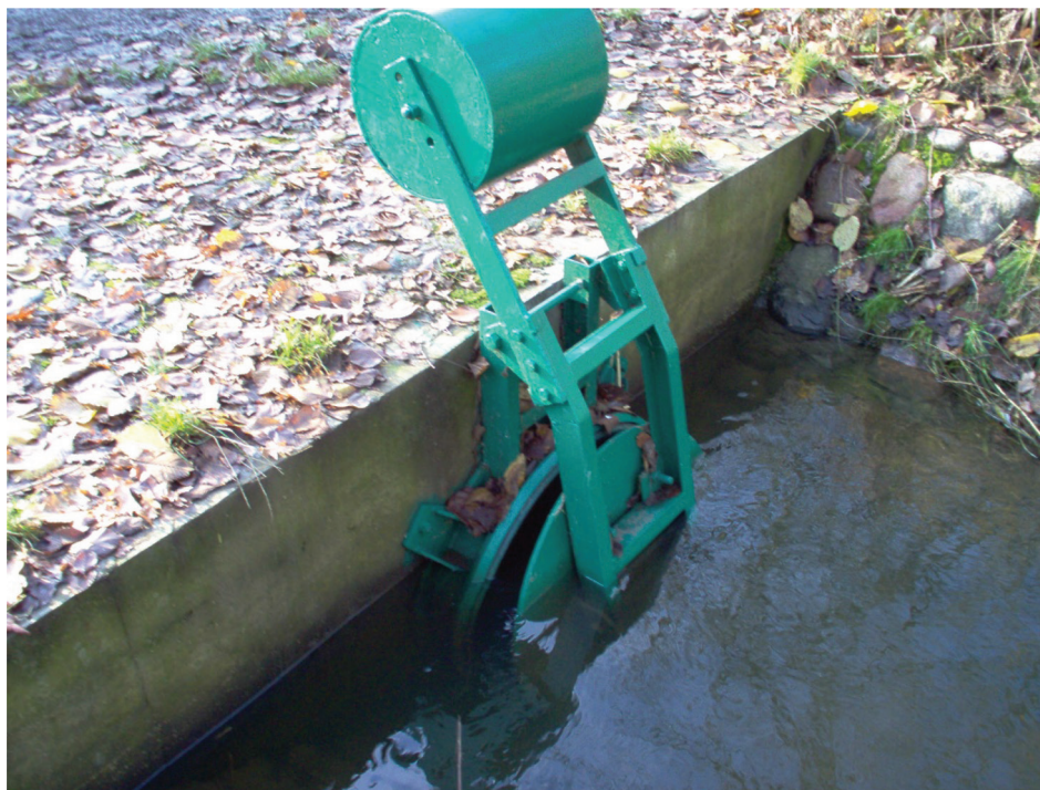
Rysunek 4. Przelew z kłapą zwrotną; Uroczysko Warta w Nadleśnictwie Jarocin (fot. A.T. Miler)
