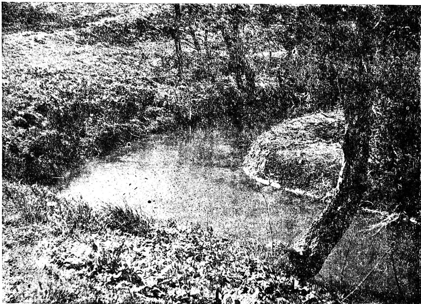
Rys. 8. Koryto rzeki w Jakubowicach. Widoczna luka w umacniającym zadrzewieniu wymaga uzupełnienia. Mimo to koryto jest zwarte i spełnia właściwie swą funkcję. 1976 r. Fot. S. Ziernicki
