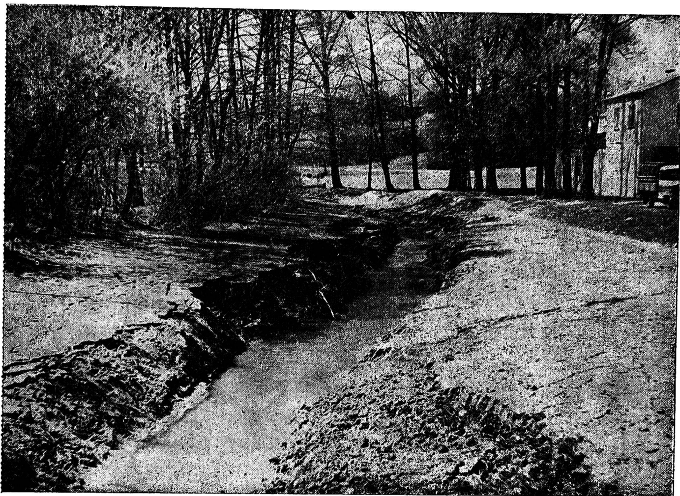
Rys. 6. Koryto rzeki w Dysie powyżej piętrzenia dla celów przeciwpożarowych. Stan po spuszczeniu wody na wiosnę 1976 r. Widoczne są osadzone namuły i wtórne ich rozmywy. Fot. S. Ziennicki
