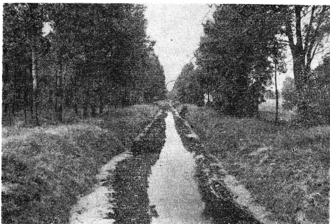
Rys. 3. Obrzański Kanał Południowy pod Brońskiem (fot. Z. Paślawski)
